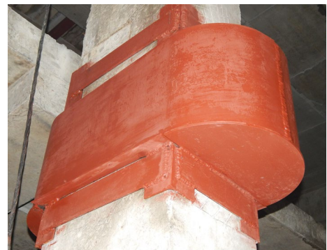
Рис. 5. Виконана метало-бетонна консоль
