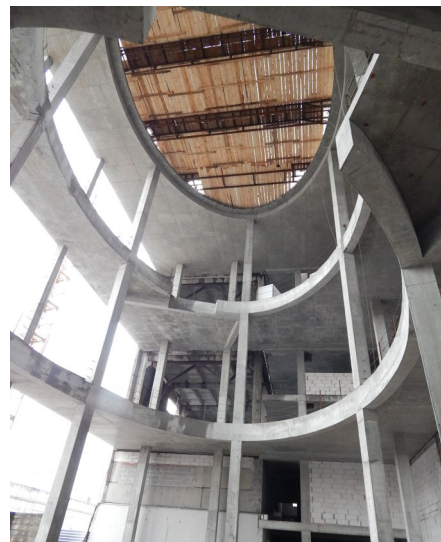
Рис. 2. Атріум овальної форми у добудованій частині будівлі
